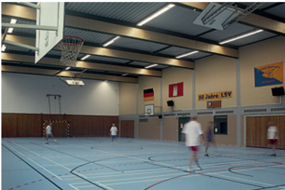
Verstärkte Deckenkonstruktion in unserer Sporthalle. 2010 kam noch der neue Boden hinzu.
